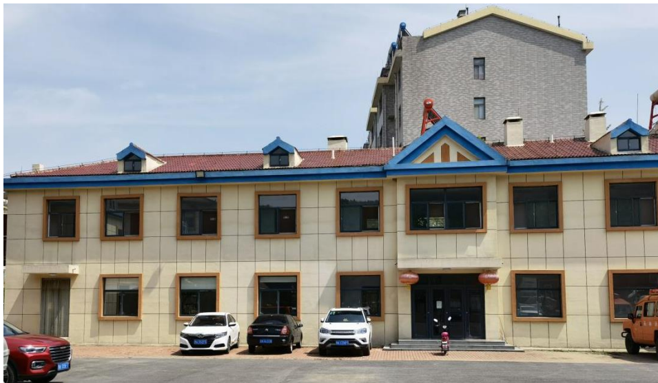
图 2.26 历城区国有黑峪林场消防驻地现场照片
