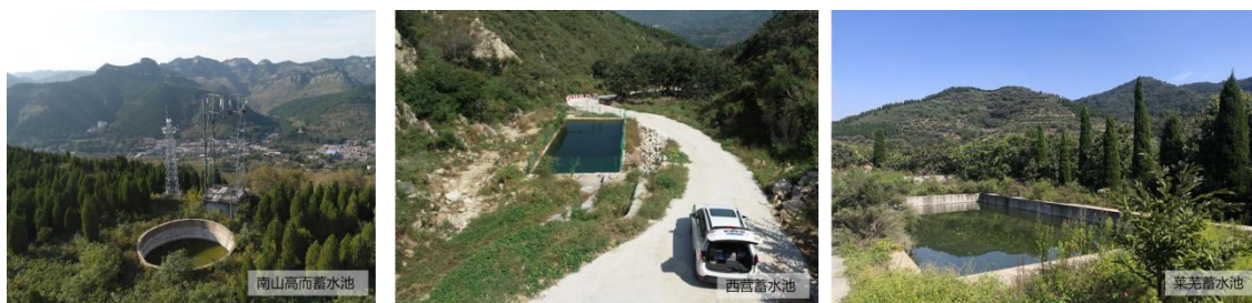
图2.25 部分地区蓄水池现场照片
