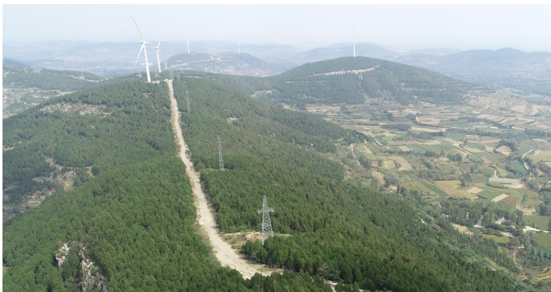
图 2.21 平阴县部分防火道路现状照片
